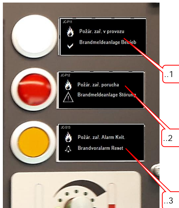
Obrázek 113 - Podrobnosti: kontrolky a ovládací prvky požárního hlásiče
