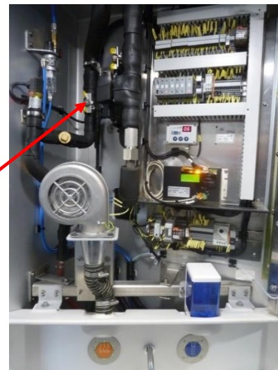
Obrázek 184 - Poloha a vzhled uzavíracího kohoutu vody
