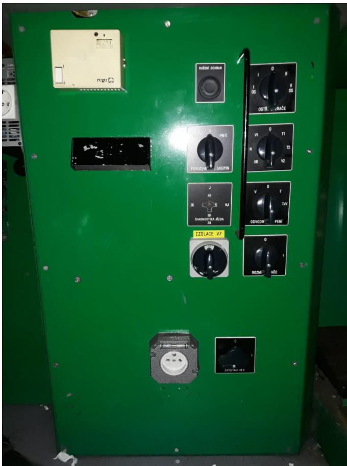
Obr. 1: Umístění přepínače „Izolace VZ“ na sloupek pod pultem
